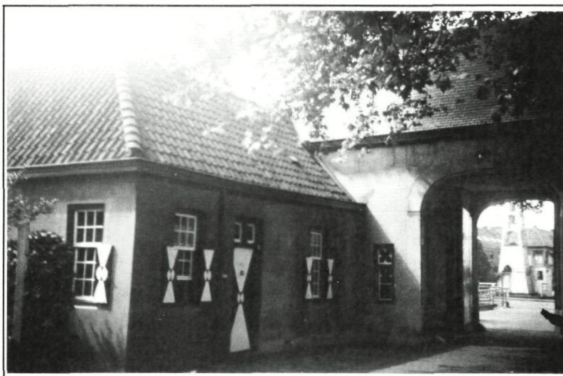
➤ Afb. 13: Notaris Keulen hield kantoor in het linkergedeelte van de oude kasteelpoort aan de Kasteellaan. Dit gedeelte is in 1959 gesloopt. Fotograaf onbekend.
