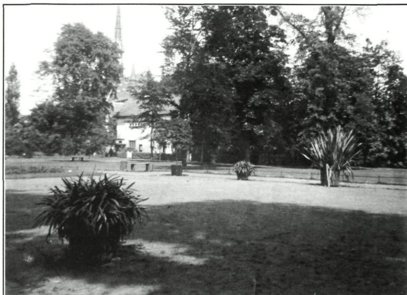
➤ Afb. 29. Het witte pand was de ambtswoning van de burgemeester aan de Smalle Haven. De H. Hartkerktorent hoog boven de rest van Helmond uit. De (onbekende) fotograaf stond in de schaduw van een duiventoren. Helemaal links in het midden van de foto is het grote bloembed te zien van foto 28.
