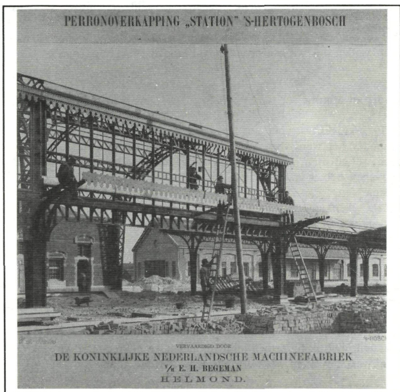
► Het station in Den Bosch in aanbouw (1895).
