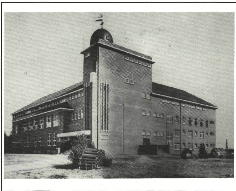
► Christus Koning in 1930. De eerste bouwfase is klaar.
