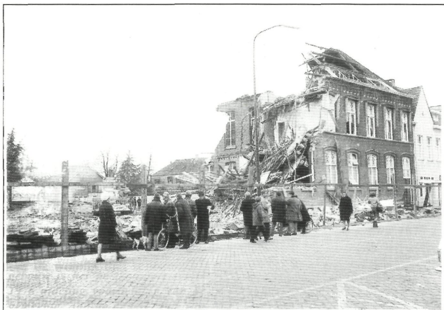
➤ De afbraak van het St. Aloysius klooster in volle gang, begin 1971 want in februari was het gehele complex verdwenen (fotograaf onbekend).
